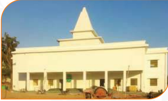
टूरिस्ट फैंसिलिटेशन सेन्टर, चित्रकूट
